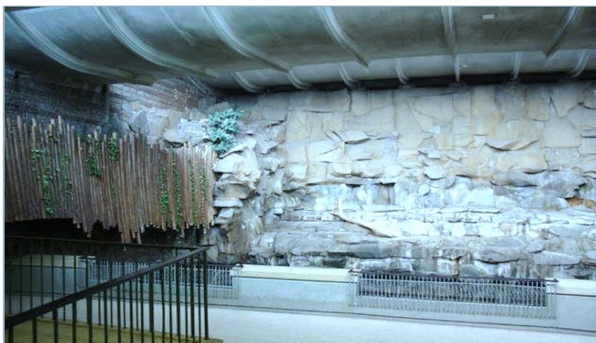
Felsenhalle im Umbau
